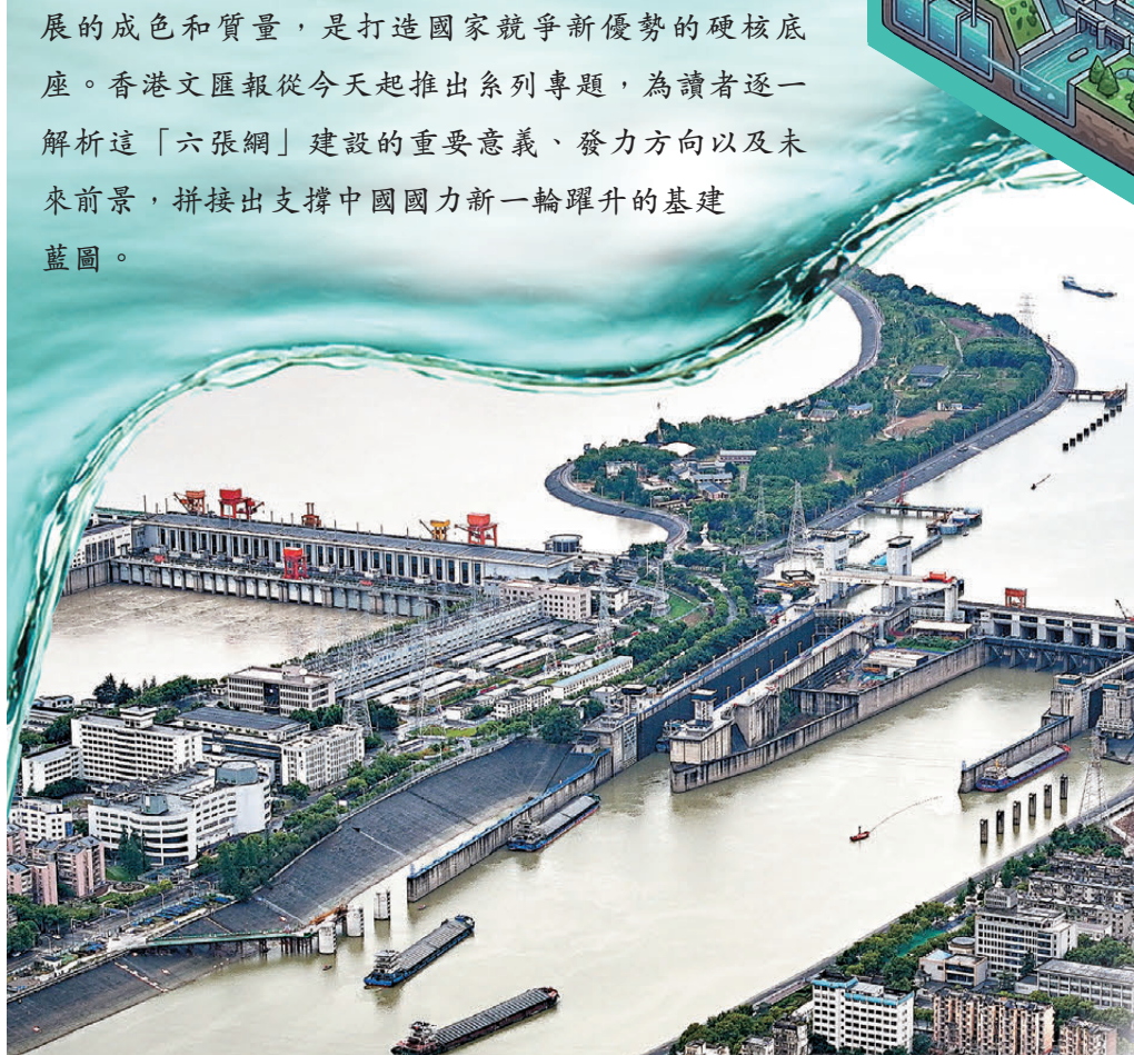
●6月8日拍攝的三峽水運新通道工程葛洲壩航運擴能施工現場。資料圖片
