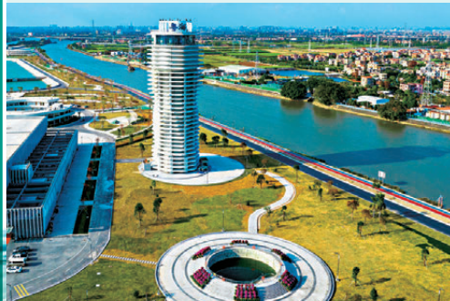
●珠三角水資源配置工程高新沙泵站。圖資委網站圖片
