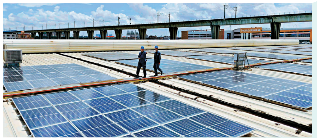
●一家企業的1.25兆瓦分布式光伏接入廣東中山市虛擬電廠。
