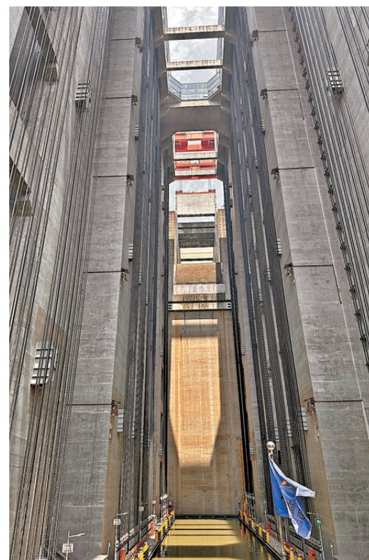
●升船機塔柱建築高度達146米，它的最大提升高度為113米，約四十層樓高。 作者供圖
