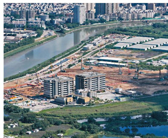
●建設中的河套香港園區。
