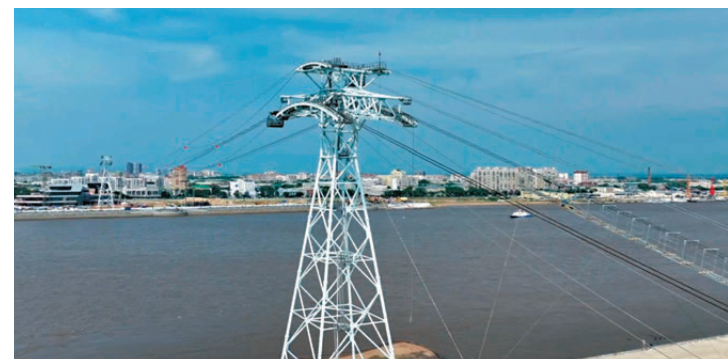
●黑河—布拉戈維申斯克黑龍江(阿穆爾河)跨境索道中方主塔架矗立在黑龍江江面上。香港文匯報記者于海江攝
