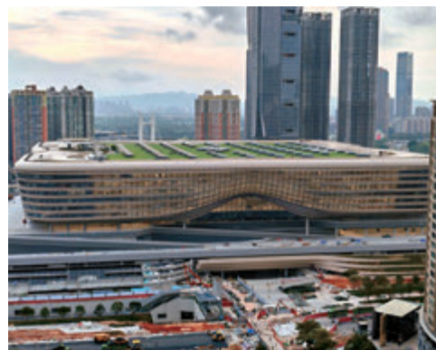
●新皇崗口岸建設項目進入開通前的收官衝刺階段。資料圖片
