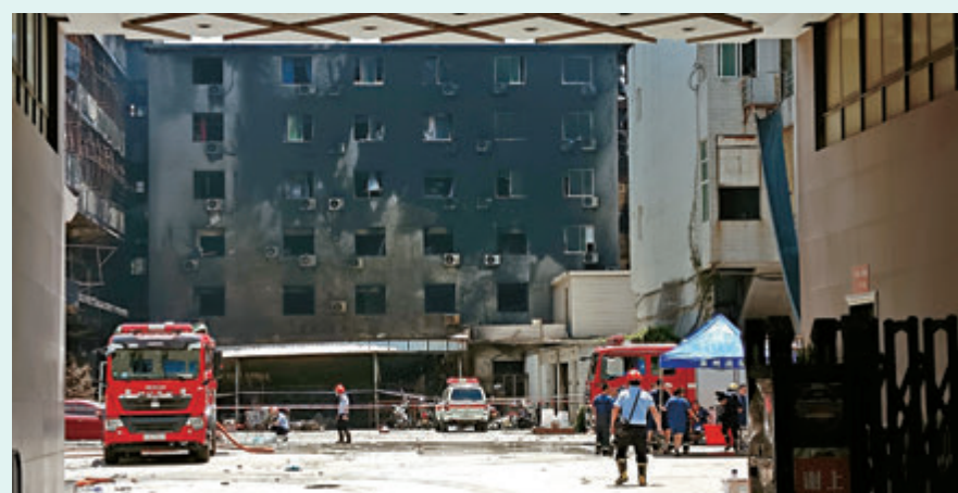
●輝騰鞋業大門直對的大樓有6層，每個窗戶外都有空調外機，大樓外立面全部被濃煙熏黑。
