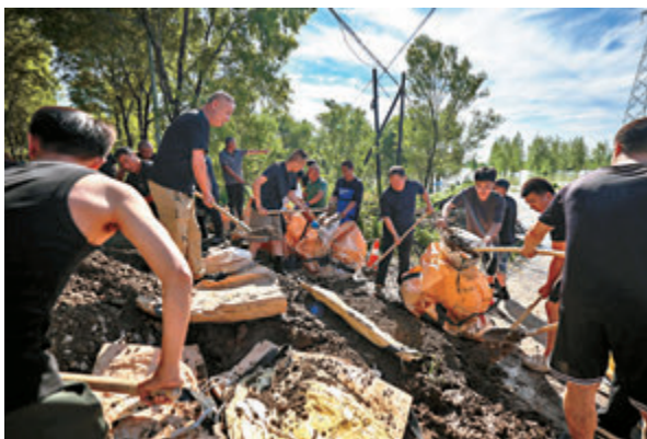
● 瀋陽市遼中區人社局部分黨員與遼中區潘家堡鎮于家台村村民一同進行堤壩加固作業。
