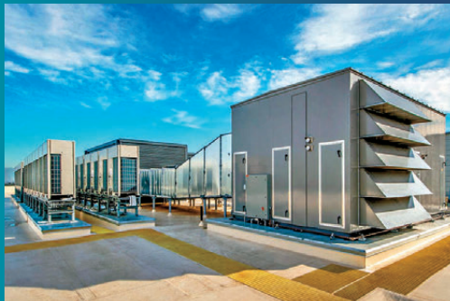
●預製艙式變電站。
