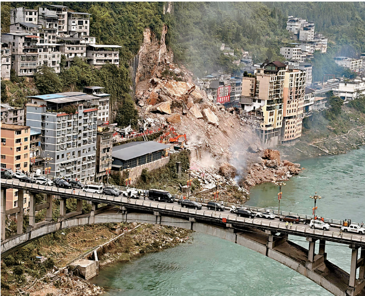
●7月17日9時許，重慶市彭水縣漢葭街道烏江三橋附近發生山體垮塌，造成房屋倒塌，有人員被困。圖為山體垮塌現場。
