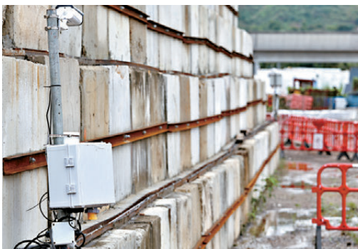
監控鏡頭正監察地盤內石柱擺放情況，以免因地面不平導致石柱出現倒塌危機。
