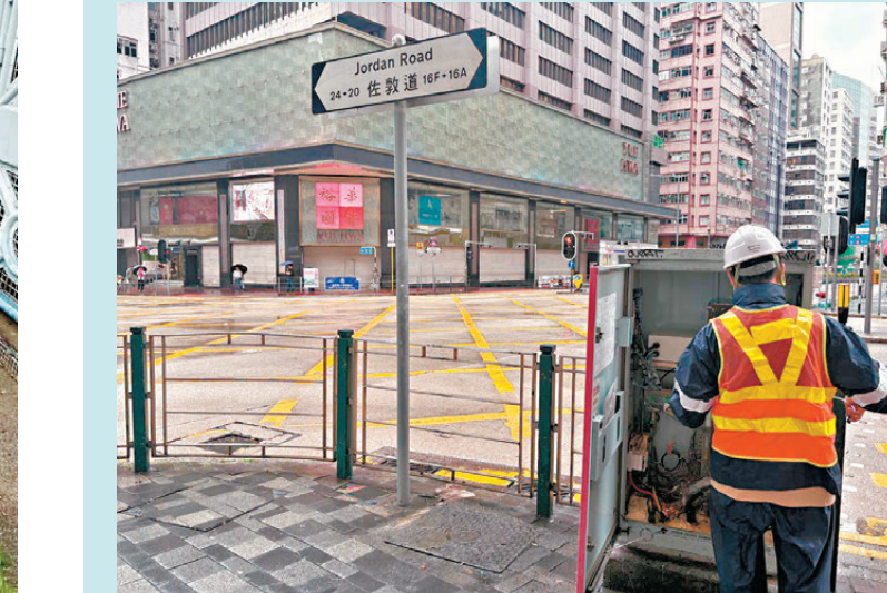
▲ 運輸署協調機電工程署與承辦商緊急維修個別故障的交通燈號控制器，讓燈控路口盡快恢復正常運作，確保交通安全暢順。 運輸署 Fb 圖片
