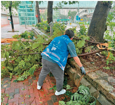
▲ 港鐵工程團隊於東鐵線進行架空電纜修復工作。 港鐵供圖
