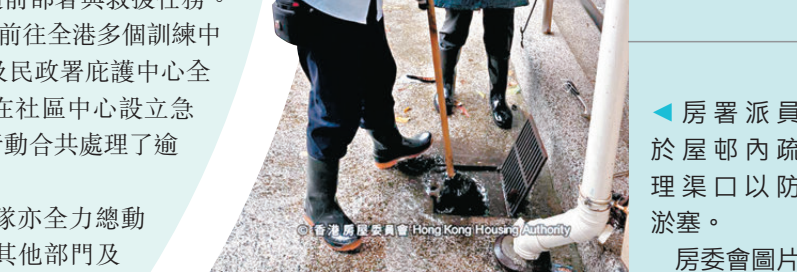
▲ 房署派員於屋邨內疏理渠口以防淤塞。 房委會圖片
