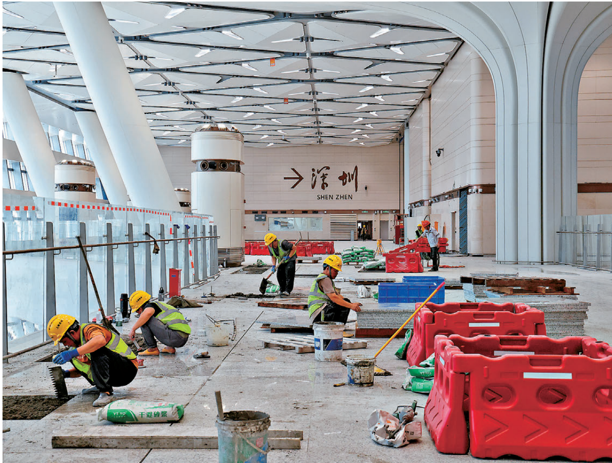
▲工人在建設中的皇崗口岸聯檢大樓內施工。 資料圖片
