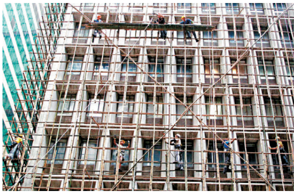
●勞工處過去兩周已派員巡查全港1,200個地盤。圖為工人在高空搭棚。 資料圖片
