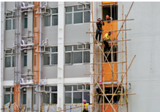
●全港逾30年樓齡的舊樓超過1萬棟，市場龐大。圖為工人維護樓宇。
