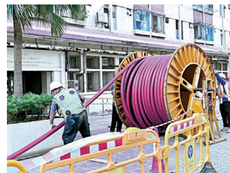
●中電工程人員鋪設臨時電纜，務求以最快速度恢復供電。 中電供圖
