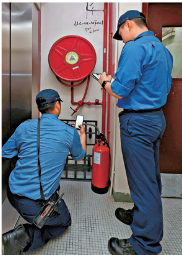
● 消防處與屋宇署1月起開展聯合行動，巡查高風險樓宇。消防處供圖
