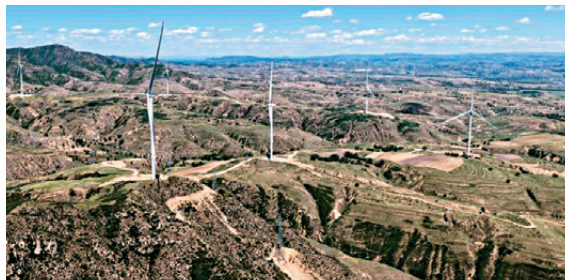
●和林格爾數據中心集群綠色能源供給示範項目風機，該項目生產的綠電可直供和林格爾數據中心集群內的算力企業。
