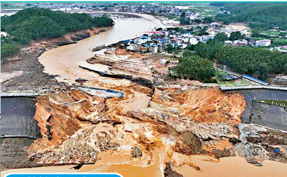
●7月初，颱風致廣西六藍水庫潰壩。截至21日，廣西南寧市、貴港市因颱風遇難159人，失聯10人。
