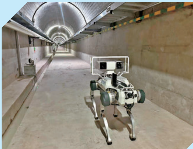
●在大藤峽水利樞紐工程全長4公里的大壩廊道裏，機器狗「巡檢員」正在對監測設施和滲漏、排水等情況開展巡檢。 網上圖片
