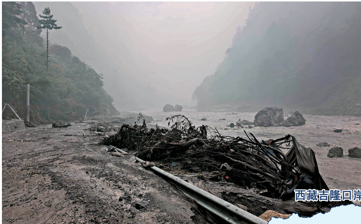
●8月26日，西藏日喀則市吉隆縣發生泥石流災害。圖為吉隆口岸附近。
