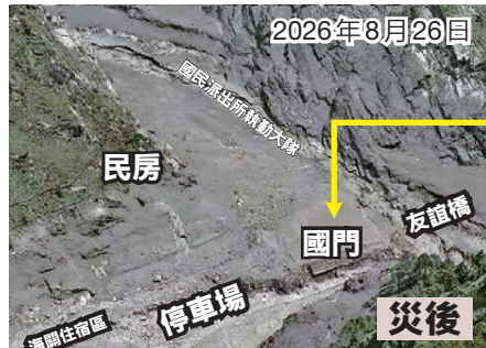
2026年8月26日 民房 國門 友誼橋 停車場 災後
