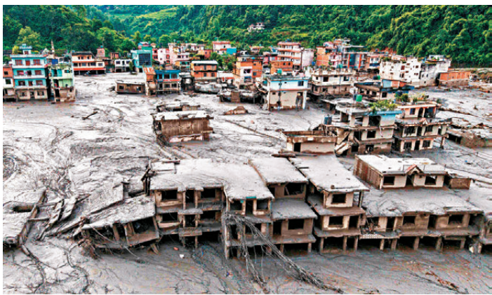
●大量房屋被泥石流淹埋。
