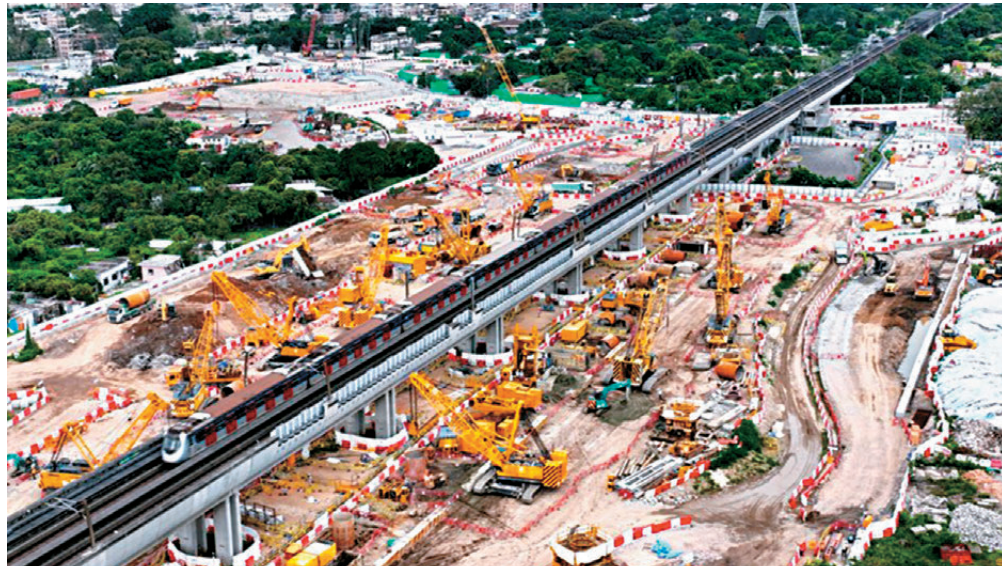
●港鐵洪水橋站的車站組件先在距離高架橋約30米的工地上組裝成主體結構，預計在明年第一季及第三季進行合攏、裝嵌及固定，成為完整的車站結構。 港鐵供圖
