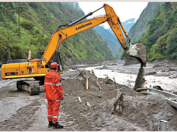
●8月28日，受災路段上挖掘機、裝載機等全力開展清淤保通作業。 中新社
