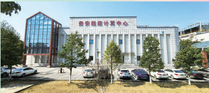
●位於貴安新區的超級計算中心。
