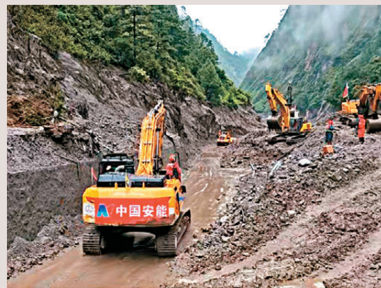
●中國安能工程力量持續開展道路搶通作業。
