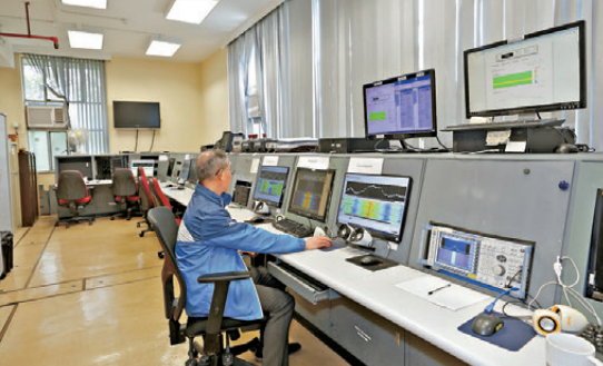
●室內監測組是全港無線電監控中樞，匯集各山頂監測站數據即時分析、監察干擾狀況。
