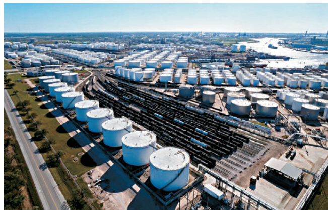
●得州迪爾帕克市沃帕克碼頭的石油儲槽。彭博社
