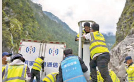
●8月30日，西藏自治區應急通信保障人員在救災一線架設4/5G基站。
