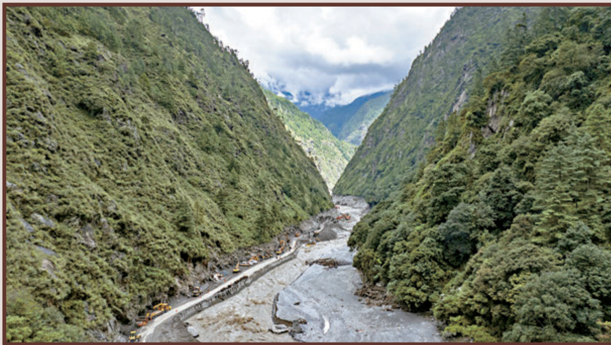
●8月30日，在吉隆泥石流災害中損毀的G216吉隆鎮至吉隆口岸路段，救援機械在開展搶修作業（無人機照片）。
