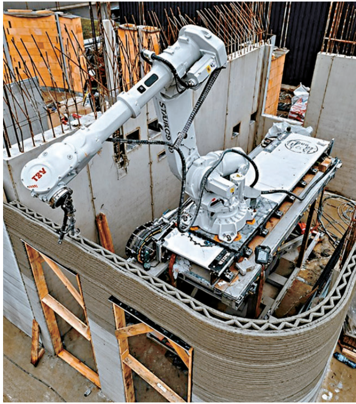
●「3D打印混凝土技術」利用自動化設備，將特製的混凝土材料一層一層堆疊起來。 網上圖片
