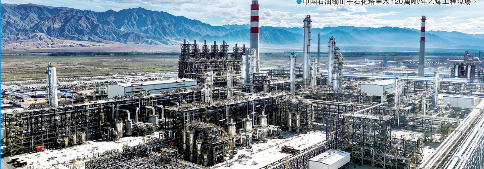
●中國石油獨山子石化塔里木120萬噸/年乙烯工程現場。
