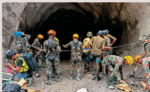
●救援人員在水電廠隧道搜尋倖存者。法新社
