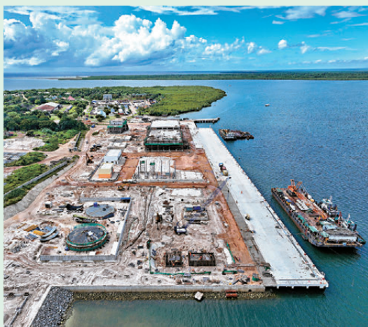
● 中國援建坦桑尼亞的基盧瓦漁港建設工地。資料圖片
