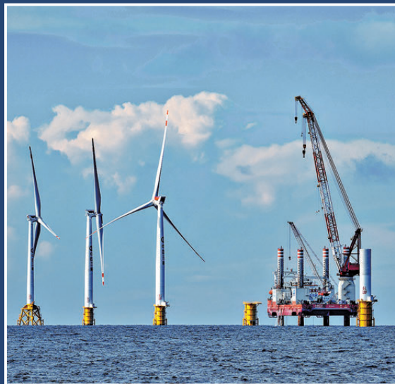
●廣東陽江海上風電基地。
