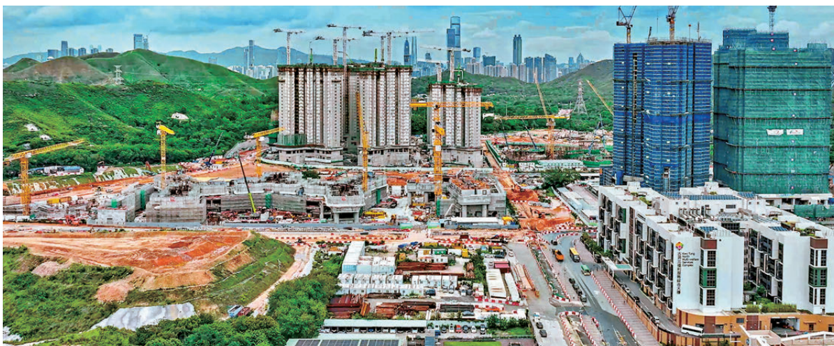
●發展局局長甯漢豪昨日表示，目前北都9個新發展區已有4個進入建設階段，涉及逾800公頃的土地工程。圖為古洞北發展區。
