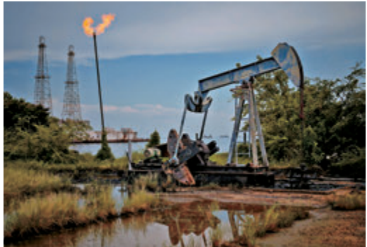
●委內瑞拉蘇利亞洲一台抽油機正在作業。彭博社
