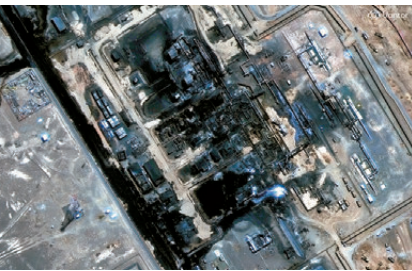
● 沙特東西輸油管日前遇襲，最新衛星圖片顯示設施損毀嚴重。路透社
