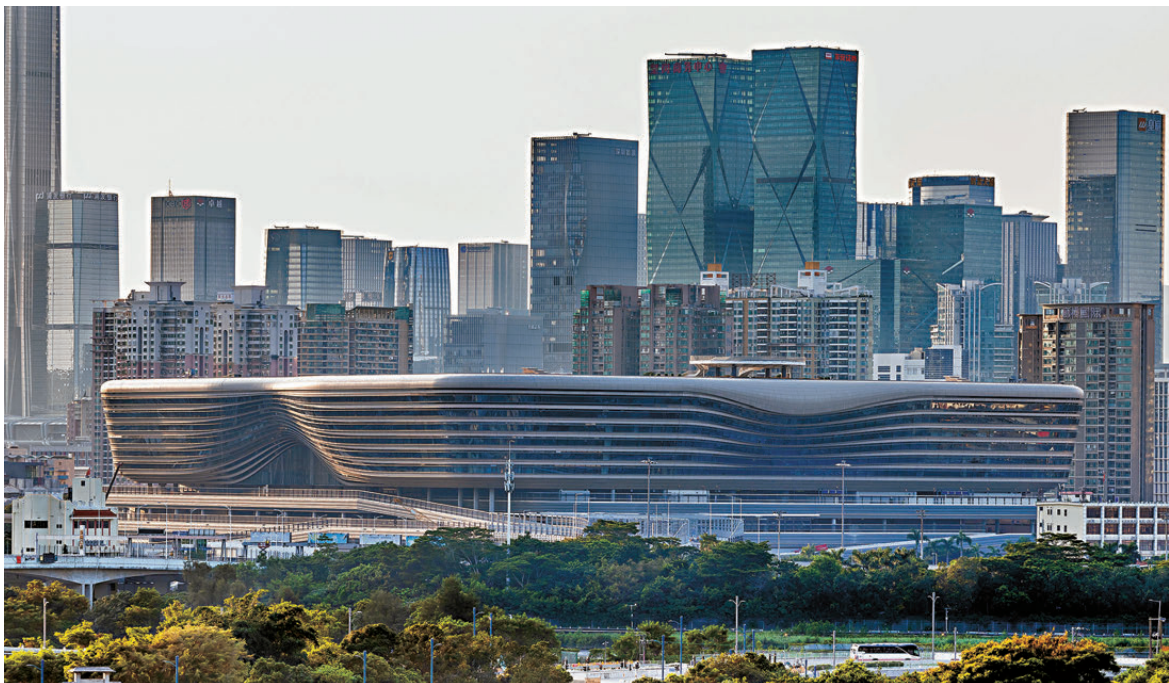
●特區政府將推進多個基建項目，提升跨境客運服務能力與水平。圖為即將通關的新皇崗口岸。
