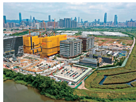
●河套香港園區的5號及6號、2號及3號大樓先後平頂，展示高效的建設速度。 港深創科園圖片
