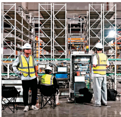
●EnerVenue在常州工廠啟動大規模生產。路透社
