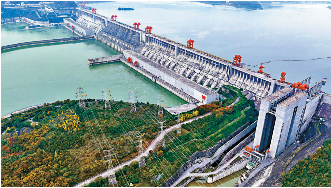
●水利部門將在「十五五」期間加快推進防洪安全體系和能力現代化。圖為湖北省宜昌市的三峽大壩和三峽電站外送輸電線路。資料圖片
