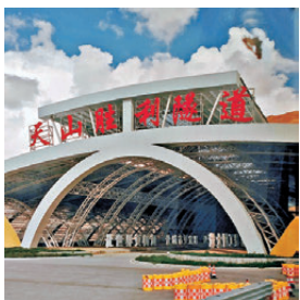
●進入「天山勝利隧道」。作者供圖
