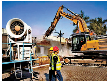
● 皇崗口岸拆除重建工程。
