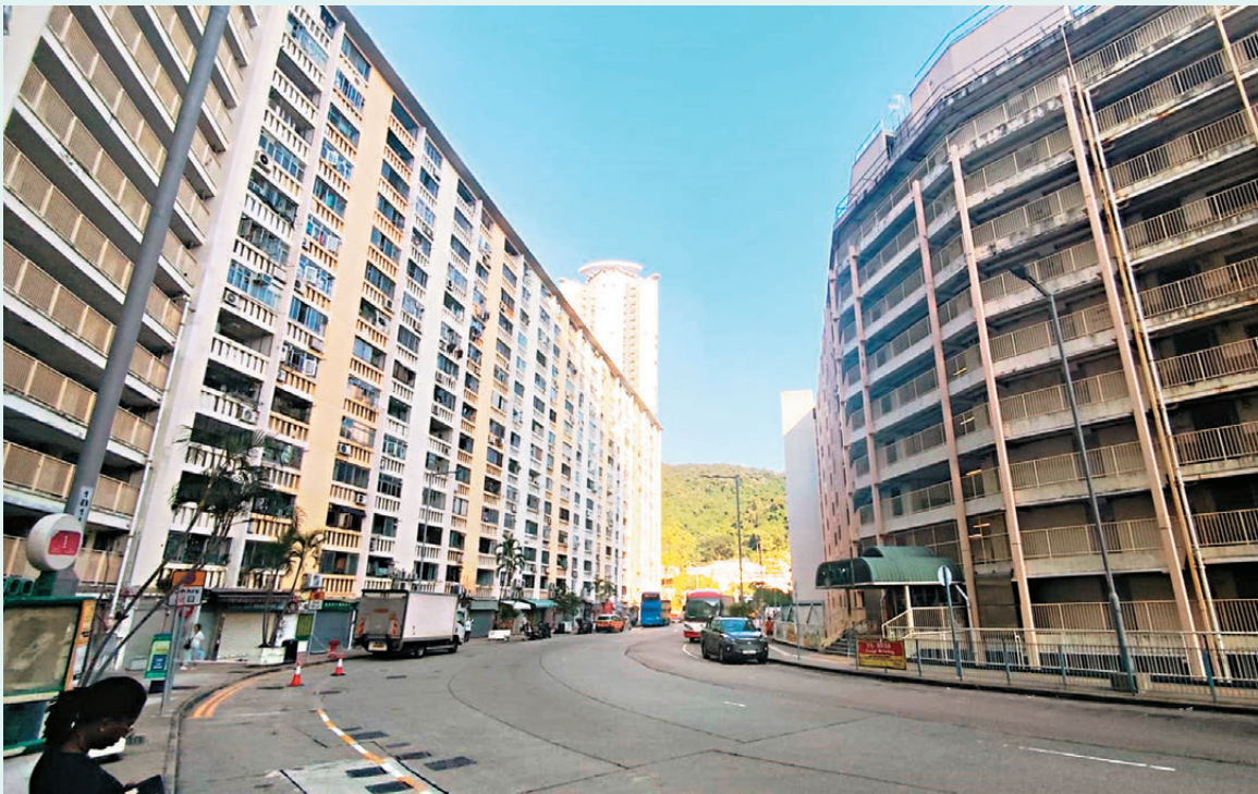
●新華富邨第一期地盤範圍內的華安樓及華樂樓將於明年第三季展開拆卸工程。
