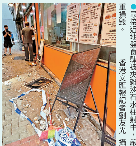
●最接近地盤食肆被夾雜沙石水柱射中，嚴重損毀。
