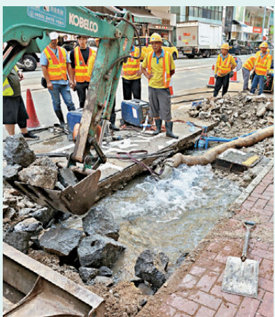
▲水務署人員全力搶修食水管。
